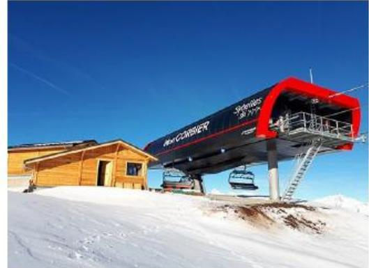
Ce débit élevé du télésiège débrayable est dû au fait que les sièges se désynchronisent du câble principal lors des arrivées en gare. Il est donc possible de les faire avancer lentement dans les gares (et éviter des chocs violents lors de la montée des passagers), et très rapidement entre deux gares (en moyenne deux fois plus vite qu’un télésiège non débrayable).
